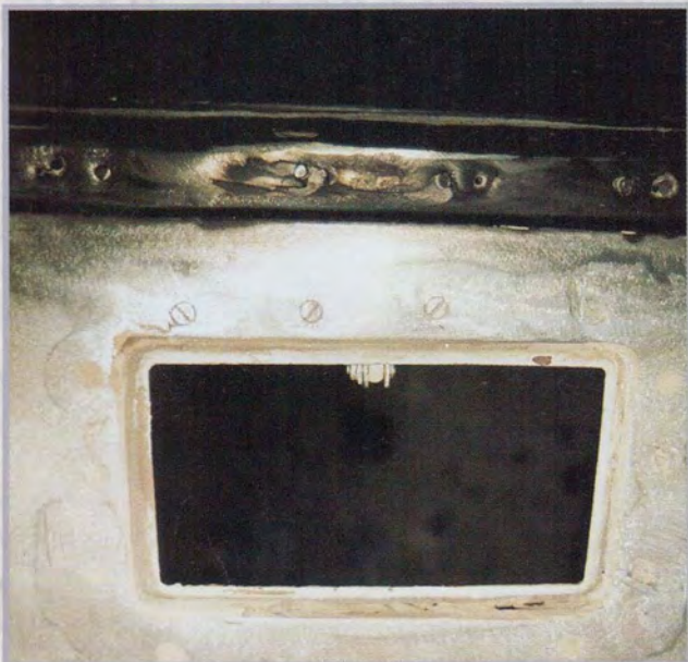
Die nicht serienmäßige Be-/Entlüftungsöffnung
